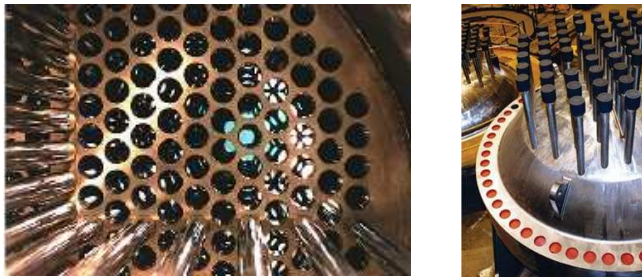
Figure 3 : photos des tubes du générateur de vapeur.
